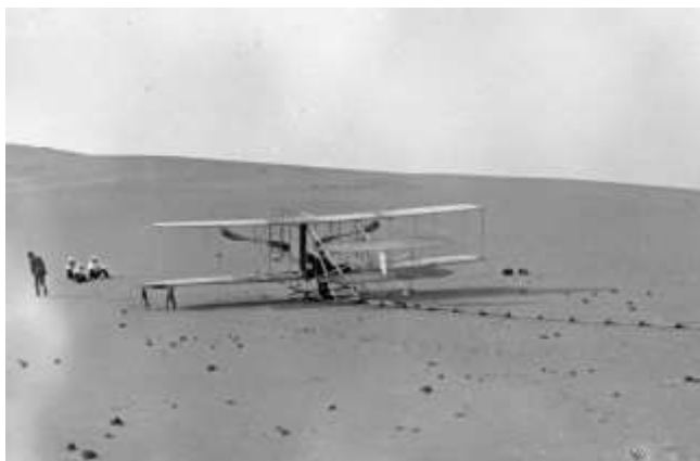
Figura 4 - O Flyer III nas dunas de Kill Devil, Carolina do Norte, 1905. Observa-se o trilho pelo qual corria a aeronave e as pás, de desenho característico, projetadas e construídas pelos irmãos Wright
