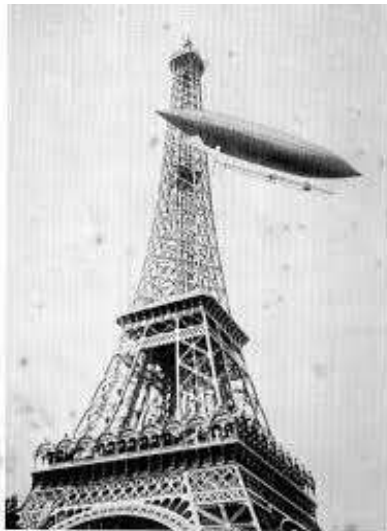
Figura 7: dirigível nº 6 dá a volta na Torre Eiffel.
