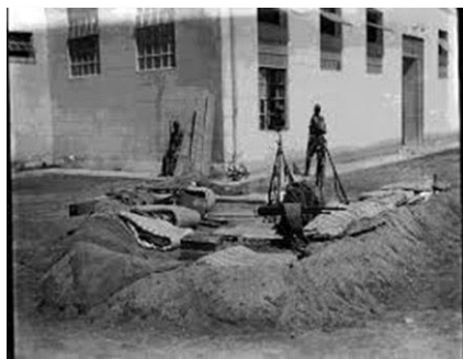
Fig 5 - Trincheiras na E Av M
